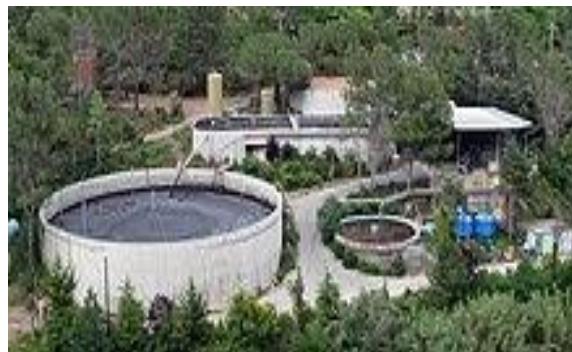
Fig. V.1. Dessablage des eaux usées
