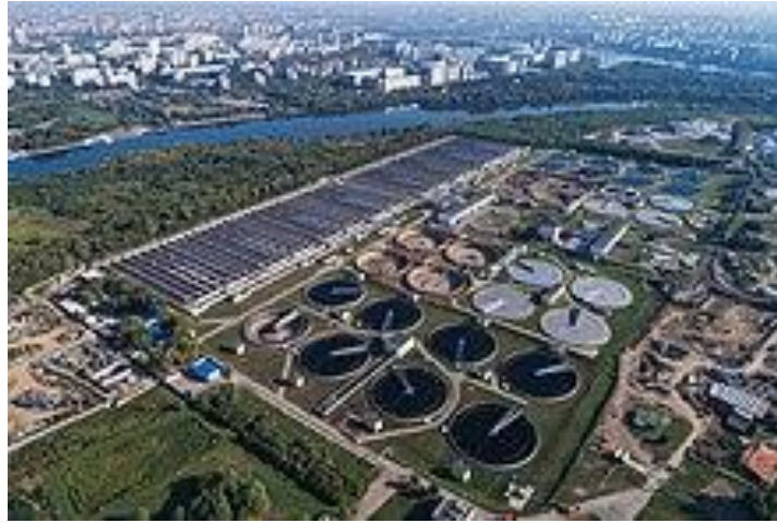
Fig. V.4. Vue par le ciel d'une station d'épuration
