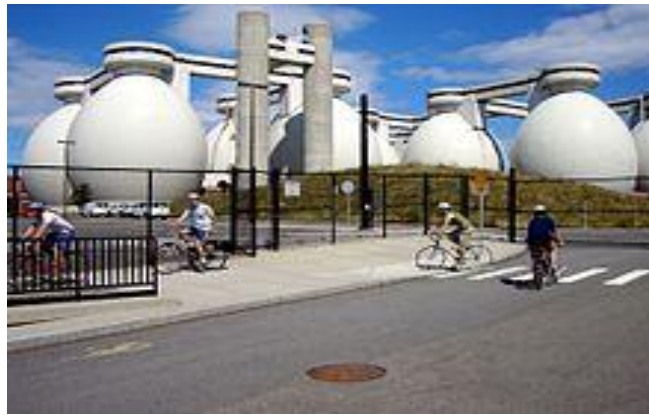
Fig.V.6. Production des biogaz dans les digesteurs
