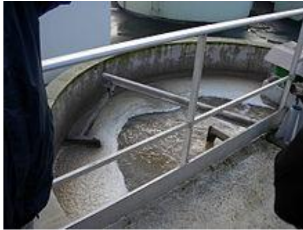
Fig .V.3.Dégraissage des eaux usées
